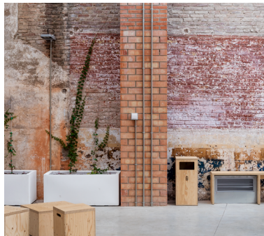
▲ Kulturzentrum La Lleialtat Santsenca, Spanien, HARQUITECTES © Adrià Goula
