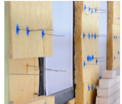
▲ Ausführungsbeispiel: Eingelegte Luftschichtanker
