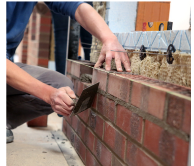
▲ Beispiel Ausführung Fugenglattstrich
