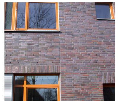
▲ Zur Vermeidung von Rissen werden der Fertigteilsturz und das Brüstungsmauerwerk durch Anordnung vertikaler Dehnungsfugen vom angrenzenden Verblendmauerwerk getrennt
