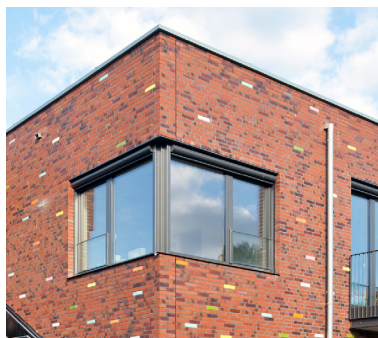
▲ Vertikale Dehnungsfuge im Eckbereich
