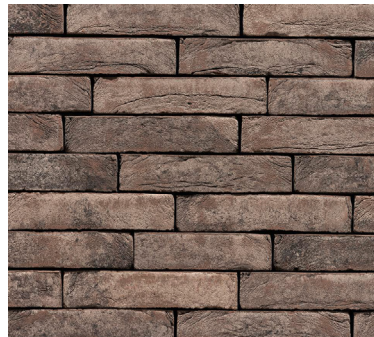
▲ Vermauern mit minimaler Fuge
