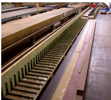
▲ In der Holzschalung sind bereits Aussparungen für die Fugen des Sturzes mit einer Auskratztiefe von 1,5 cm berücksichtigt
