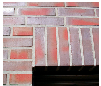
▲ Das senkrecht angeordnete Widerlager kann keine tragende Funktion übernehmen
