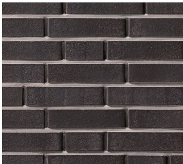
▲ Verschiedenfarbige Fugen: Stoß- und Lagerfuge
