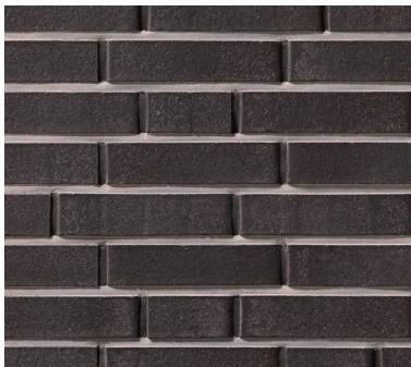
▲ Verschiedenfarbige Fugen: Stoß- und Lagerfuge
