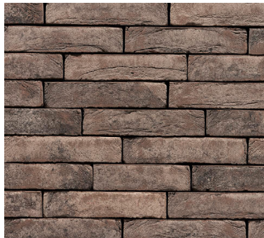
▲ Vermauern mit minimaler Fuge
