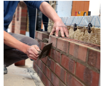
▲ Beispiel Ausführung Fugenglattstrich
