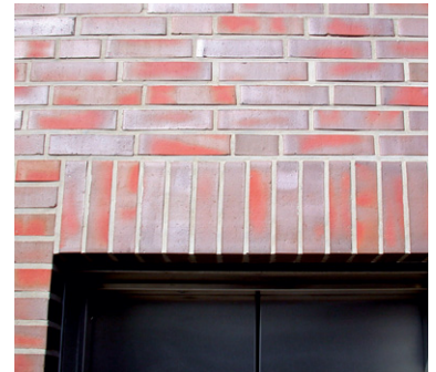
▲ Stürze aus gemauerten Grenadierschichten gelten als Schwachstelle des Verblendmauerwerks
