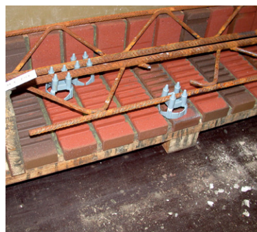
▲ Die profilierten Winkelriemchen werden unter Einhaltung der Sturzfügen in die Schalung per Hand eingelegt
