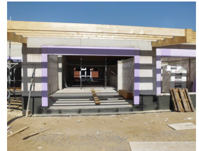
▲ Sockelanschluss Fensterbereich © Alexander Osthues
