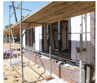
▲ Z-Abdichtung im Fensteranschlussbereich © Alexander Osthues
