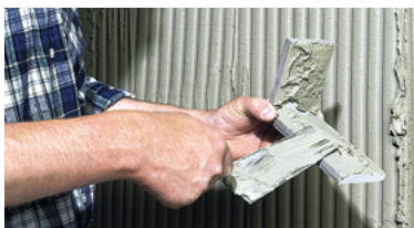
▲ Klebeauftrag im kombinierten Verfahren „Buttering-Floating“
