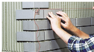
▲ Setzen der Flächenriemchen mit Hilfe einer Schnur
