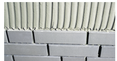
▲ Keramische Riemchen vollständig in Kleber eingebettet
