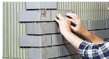
▲ Setzen der Flächenriemchen mit Hilfe einer Schnur
