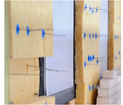
▲ Ausführungsbeispiel: Eingelegte Luftschichtanker
