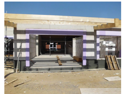
▲ Sockelanschluss Fensterbereich © Alexander Osthues
