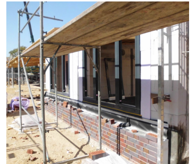
▲ Z-Abdichtung im Fensteranschlussbereich © Alexander Osthues
