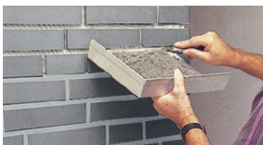
▲ Sauberes Verfugen mit Fugeisen und Fugblech
