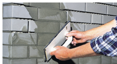
▲ Im Schlämm-Verfahren werden die Fugen diagonal mit einem Putzbrett verfüllt
