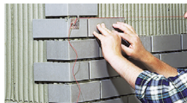
▲ Setzen der Flächenriemchen mit Hilfe einer Schnur
