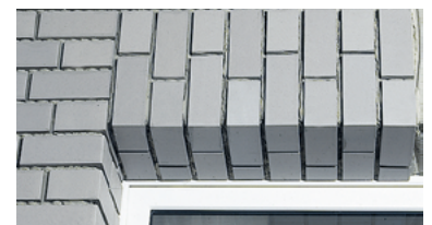
▲ Ein mit Winkelriemchen und geschnittenen Flächenriemchen nachgebildeter Sturz
