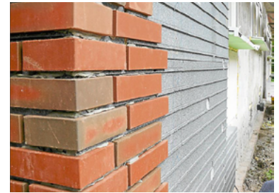
▲ Beispiel eines Fugenleitsystems als Alternative
