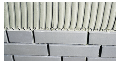
▲ Keramische Riemchen vollständig in Kleber eingebettet
