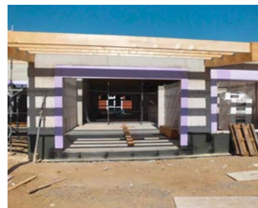
▲ Sockelanschluss Fensterbereich © Alexander Osthues
