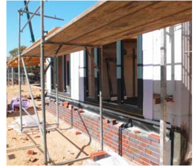
▲ Z-Abdichtung im Fensteranschlussbereich © Alexander Osthues
